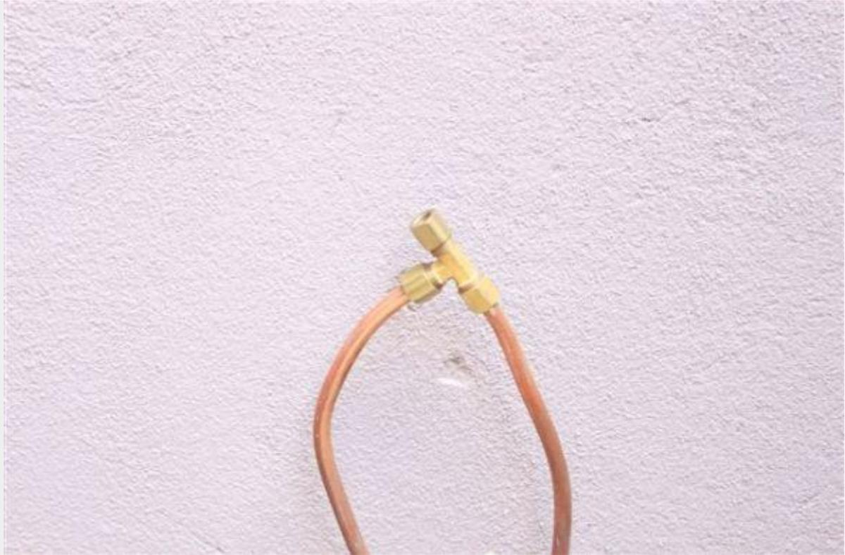
... bem próximo ao gás. Não temos certeza se pode ser usado um só duto de gás, com um T apenas na distribuição entre os dois aparelhos, mas achamos que não é o ideal. A vazão provavelmente será baixa e poderá ser difícil ter uma boa eficiência se for usar o forno na mesma hora que o cooktop. No nosso caso, como a interseção fica próximo a mangueira que tem o maior diâmetro, temos uma maior vazão distribuída ao longo de duas linhas de gás.
