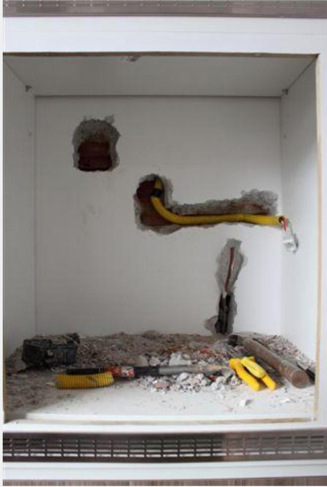
Usamos o mesmo tipo de conexão que usamos na instalação do cooktop para conectar o duto do gás à “mangueira” do forno.
