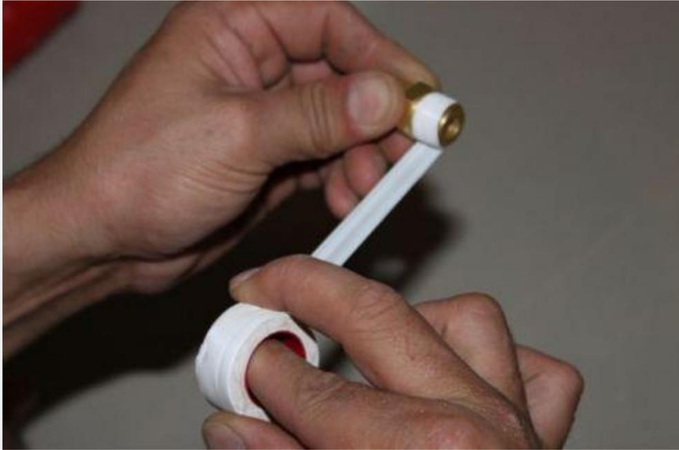
Agora que usamos o teflon na conexão 3/8" NPT, vamos uni-la ao “rabo de tatu” – que fará de fato a transição do tubo de cobre para a mangueira do gás.
