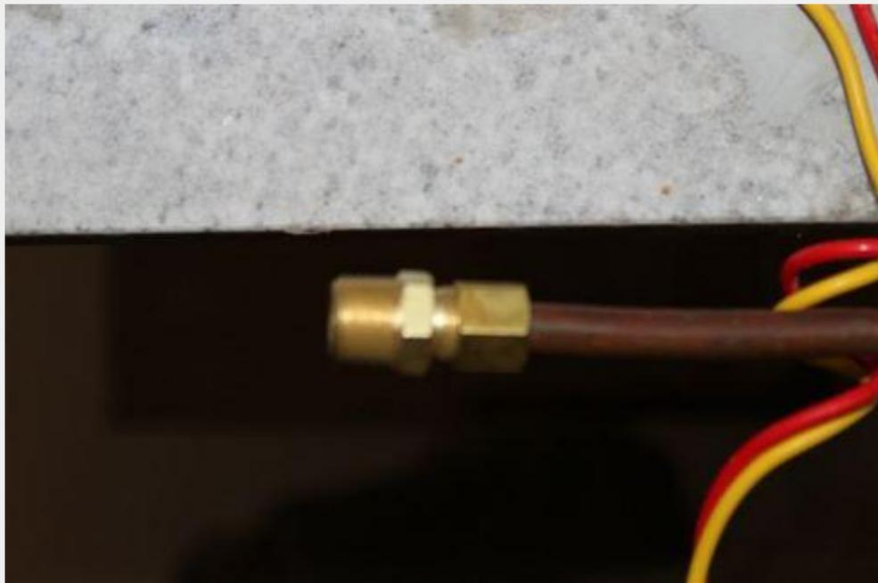
Agora que a conexão tipo anilha está no lugar, vamos retirar a ponta que você está vendo na foto de cima para fazer a conexão com outra parte (Lembra que dissemos que uma das partes iria ser removida? Então. . .). Antes disso, precisamos passar teflon.
