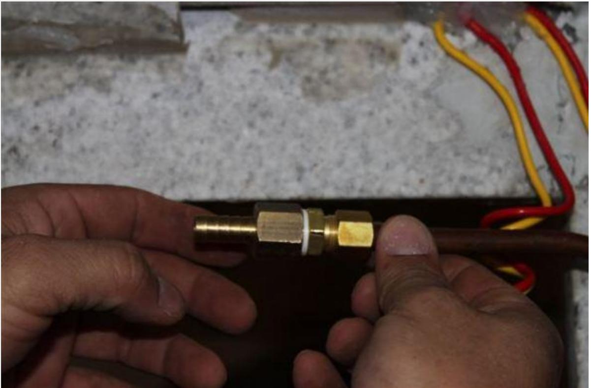
Aperte bem a conexão para evitar vazamentos.
