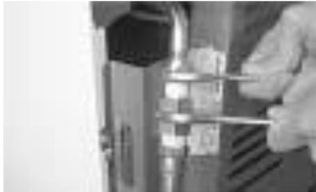
3. Coloque a porca do adaptador na entrada de gás. Em seguida, encaixe o adaptador e rosqueie a porca de fixação. Utilize duas chaves de boca para auxiliar o aperto.
