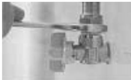
6 -Rosqueie a mangueira metálica no registro de gás com o auxílio de duas chaves de boca. Utilize fita Teflon® ou pasta vedante para auxiliar na vedação.
